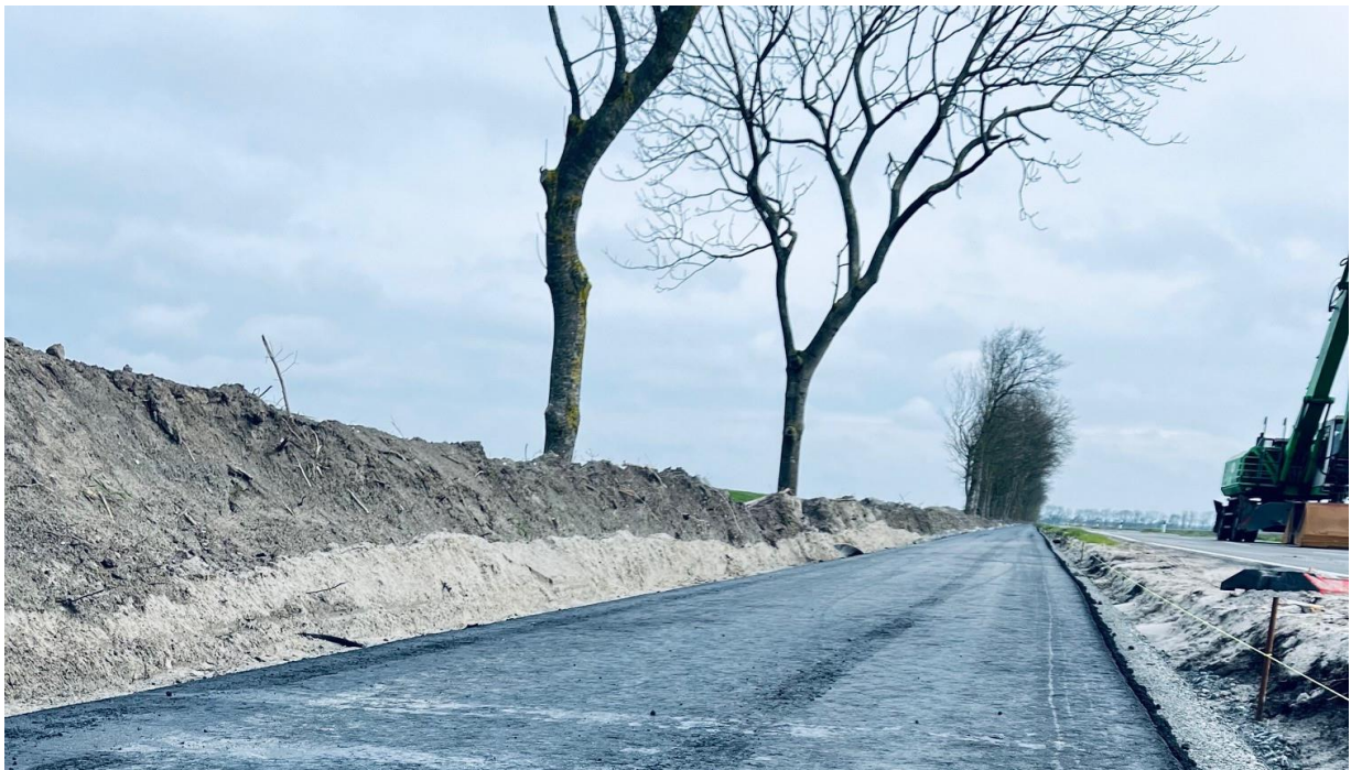
Entlang der L27 entsteht zwischen Greetsiel und Neuwesteel der erste Bürgerradweg Ostfrieslands. Foto: NLStBV
